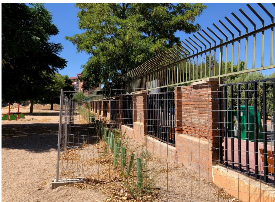
Deterioro de ladrillos, cubremuros y albardilla.
