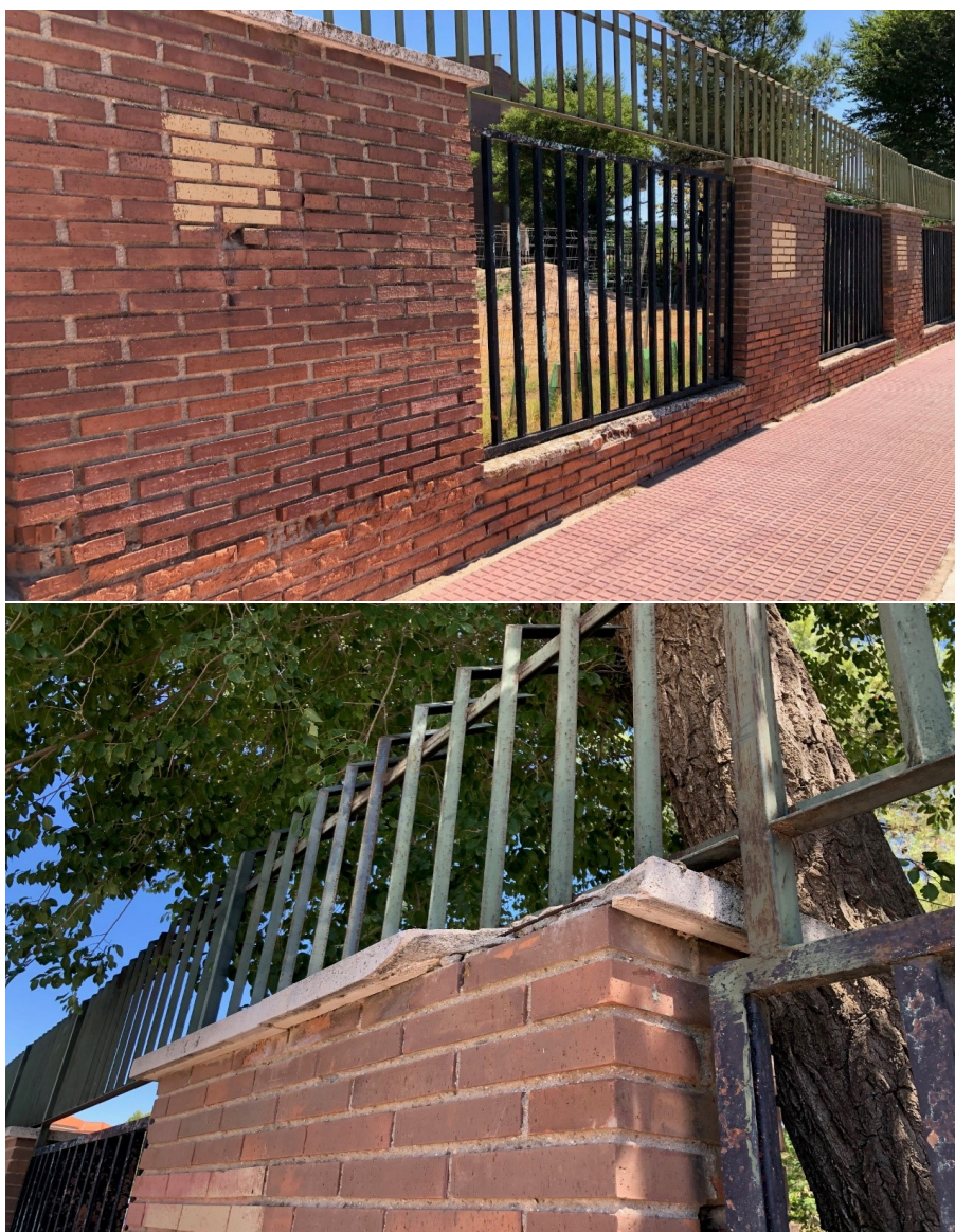
Oxidación y corrosión de la cerrajería.
